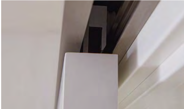
Befestigung einer Holztür im Schiebetürbeschlag Line
